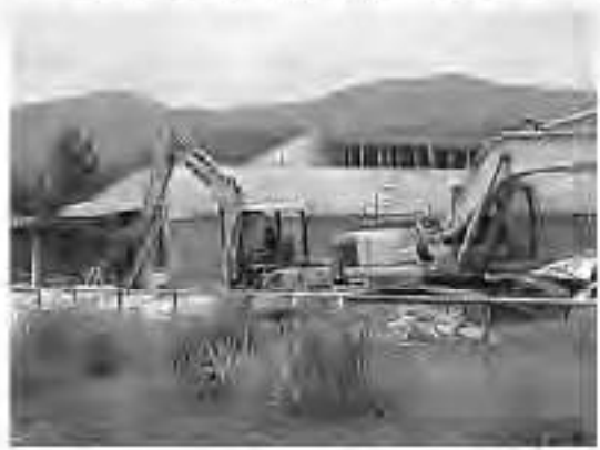
解体工事中の旧寿山荘
